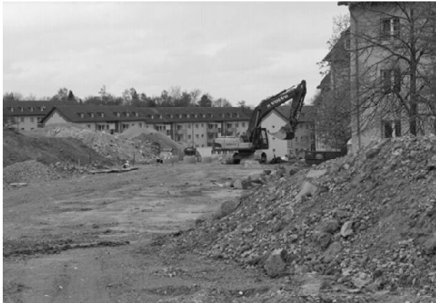
Mietwohnungen werden abgerissen. Dafür werden teure Eigentumswohnungen gebaut.
